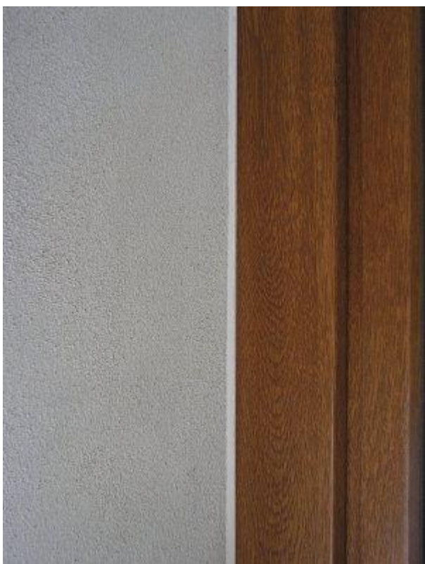
Při použití APU lišt je provedení ostění krásně čisté a bez prasklin
